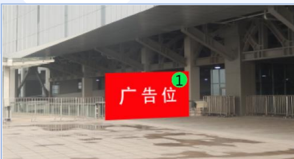
C03 东/西登录厅入口两侧落地看板
